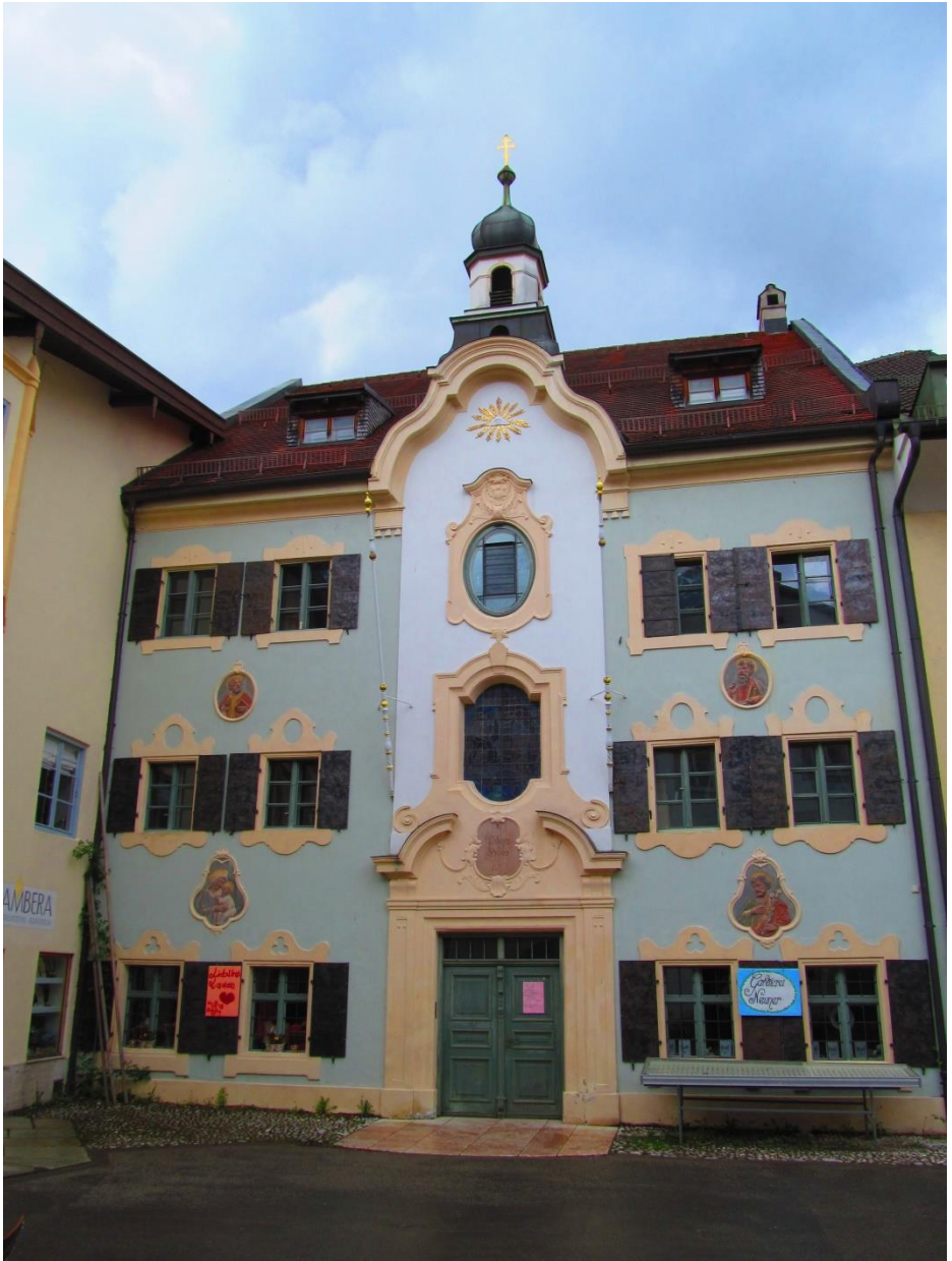
Pilgerhaus mit dem großen Torzugang & Flur mit Zugängen zu Geschäften (Untergeschoss) und Aufstieg zur Kapelle (1. Etage) © Thomas Raffael 2021
